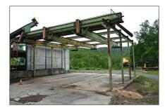
TRIPLE OVERHEAD TRAILER **LOADING SYSTEM**
